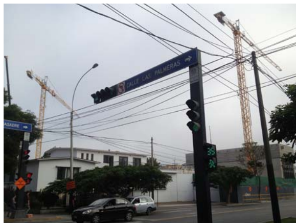
Grúa Potain suministrada por Ibergrúas.
